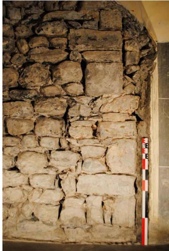
Fig. 11 – Chaîne d'angle située à l'intersection du mur nord de l'aile sud et d'un mur de refend roman. La partie inférieure est reprise en sous-œuvre à la période gothique pour l'aménagement d'une porte vraisemblablement monumentale. Photo D. Jouveau
