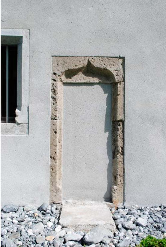
Fig. 16 – Porte à accolade (POR 1040) percée dans le mur sud de l'aile sud (UM 1003). Cette ouverture se situe dans l'axe de la grande porte gothique identifiée dans le mur nord de la même aile. Photo D. Jouneau
