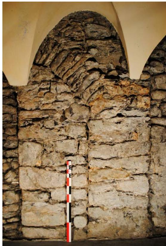
Fig. 14 – Pile d'angle des galeries est et sud modernes du cloître. L'arcade ouvrant sur la galerie orientale (à gauche de la pile) est condamnée obstruée au cours du XIXe siècle.
