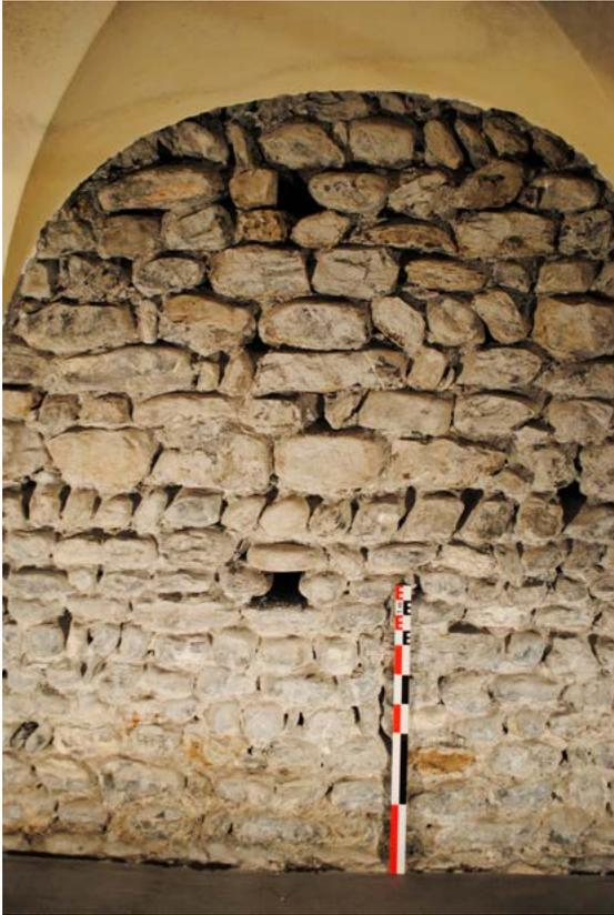
Fig. 10 – Détail du parement roman de l'aile sud (mur sud du couloir du logis). Deux trous de boulin traversant témoignent de l'échafaudage mis en place lors de la construction. Appareil de l'élévation sud. Photo D. Jouneau
