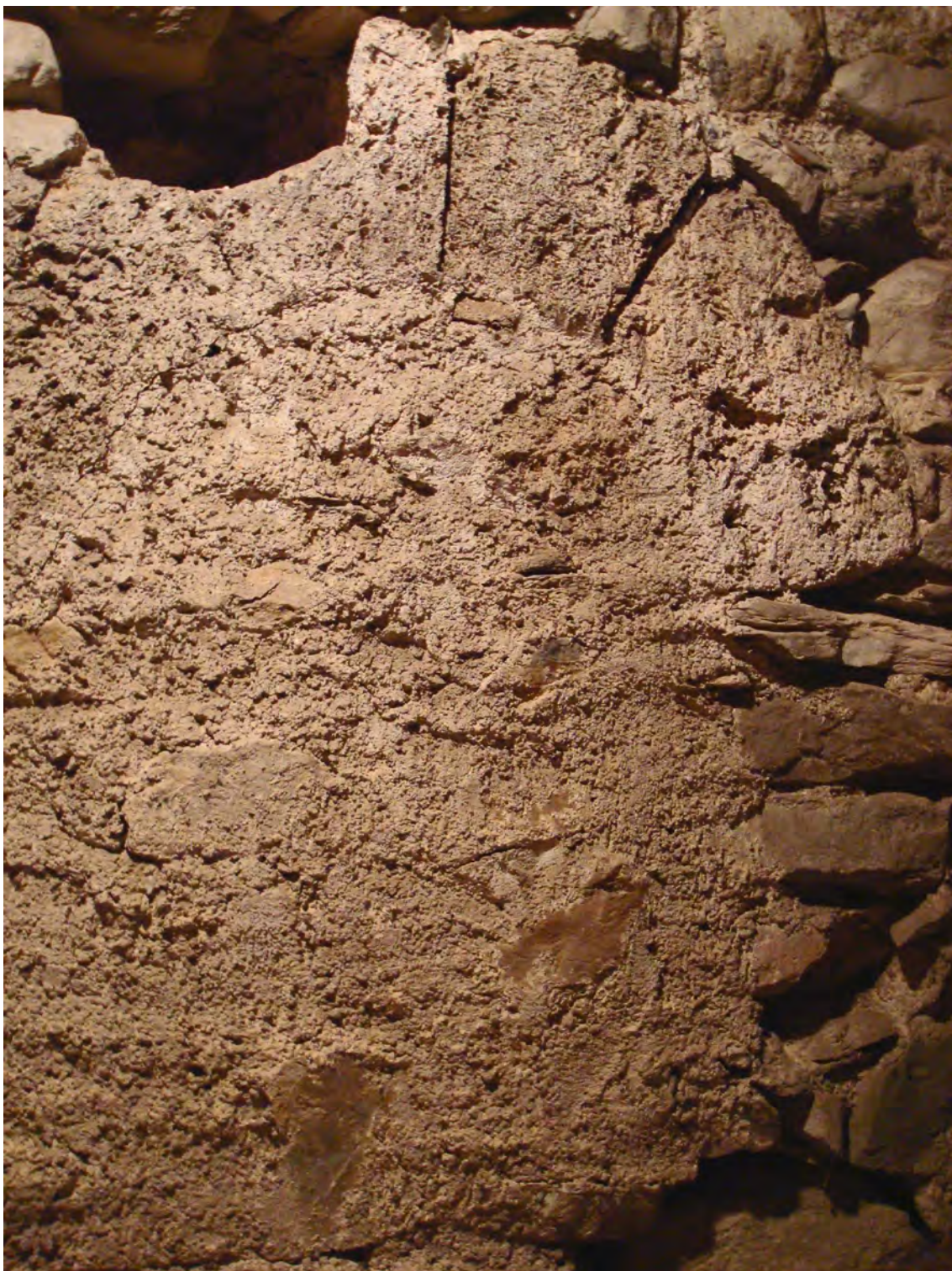
Fig. 5. Baie aux claveaux de tufs visible dans le mur sud de la première travée. Photo S. Bochaton.
