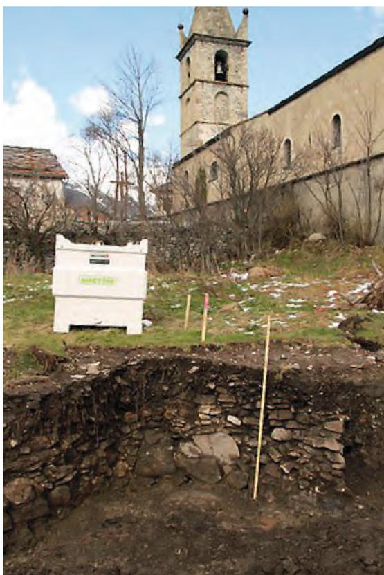
Fig. 5. Vue des murs en pierres sèches mis au jour lors des terrassements du printemps 2013. Cliché: R. Chemin.
