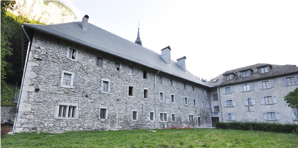
Fig. 7. Logis, façade sud après dépose des enduits.
