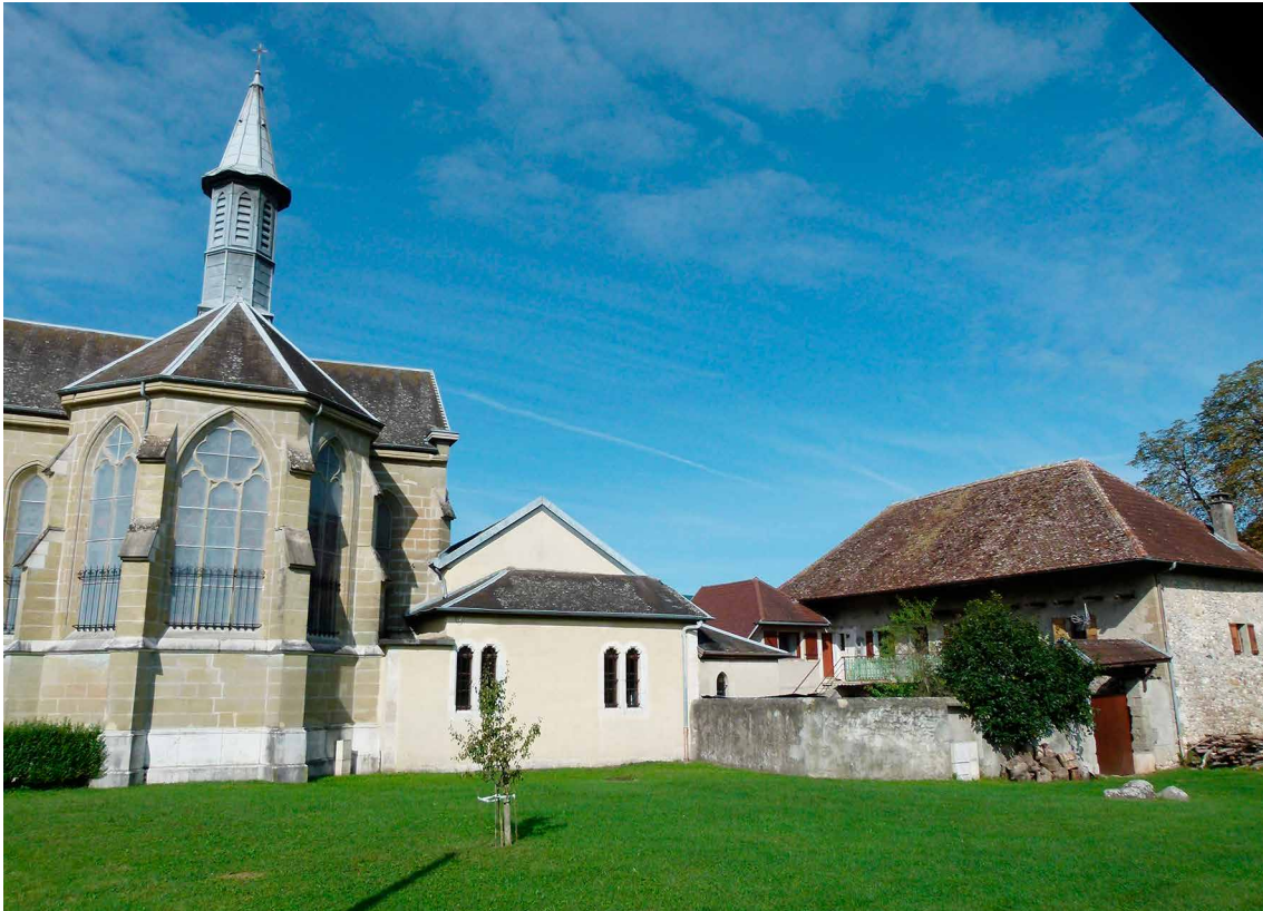
Fig. 10 – Le site de l'Aumône aujourd'hui vu depuis le sud-est. Cl. S. Bochaton
