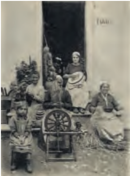
« Villard-sur-Doron, travaux d'hiver ».
