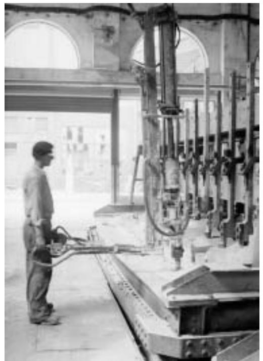
*Piquage de cuve électrolyse, usine électrométallurgique Péchiney, Saint-Jean-de-Maurienne, 1953, coll. Léger.*
