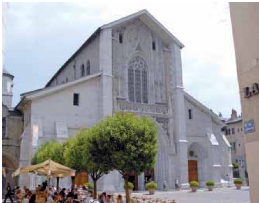
La façade restaurée.
