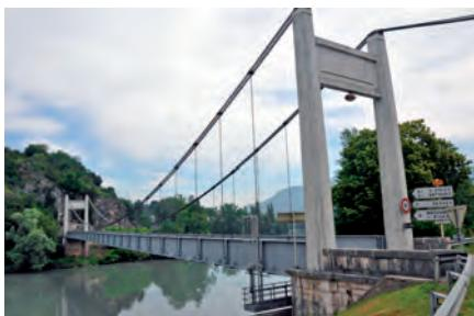
Pont suspendu à ossature mixte en béton armé et métal sur le Rhône, Nattages-Yenne. Ce pont détruit en 1940 fut reconstruit en 1950-51.
