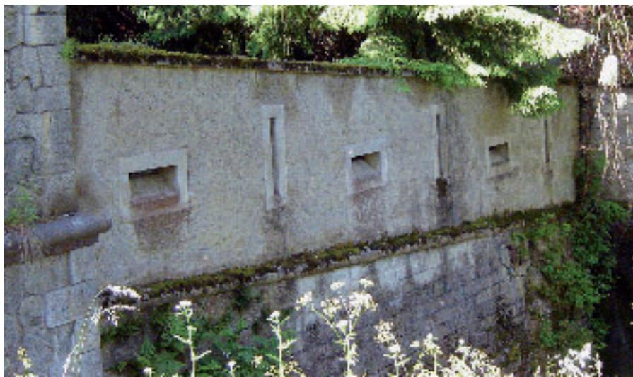
Vue du mur d'escarpe du Fort du Mont. À noter qu'une partie du parement a été remontée (partie dévégétalisée sous les créneaux à fusils).
