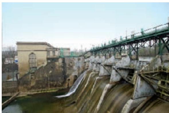
[ci-dessus] Détail du barrage à crémaillères de la centrale hydro-électrique de Vallières avant les travaux de rénovation de 2012.
