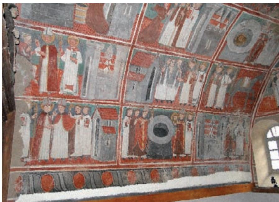
Dans la frise inférieure du décor, pose d'un bandeau de compresses de pulpe de papier pour absorber les sels.
