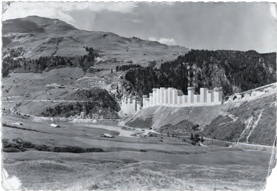
Roselend (Savoie), alt. 1.475 m. Construction du barrage. Vue d'ensemble, au loin le Col du Pré. 73034-209.
