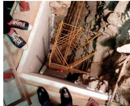
Le renforcement béton des piliers.
