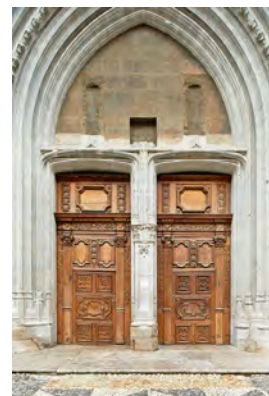
Détail du portail après restauration.
