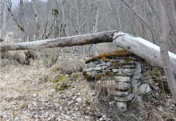
Canal d’amenée des moulins de la Settaz.
