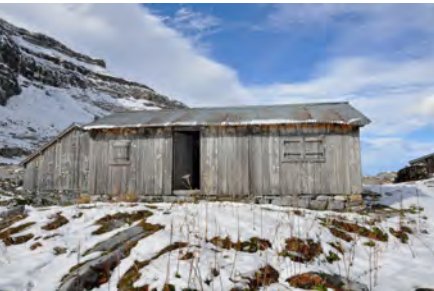
[Figure 4] Un chalet de Sales en octobre 2018. Le bâti existant.
