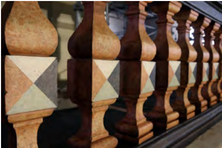
Détail décor de la balustrade de la tribune, après restauration.
