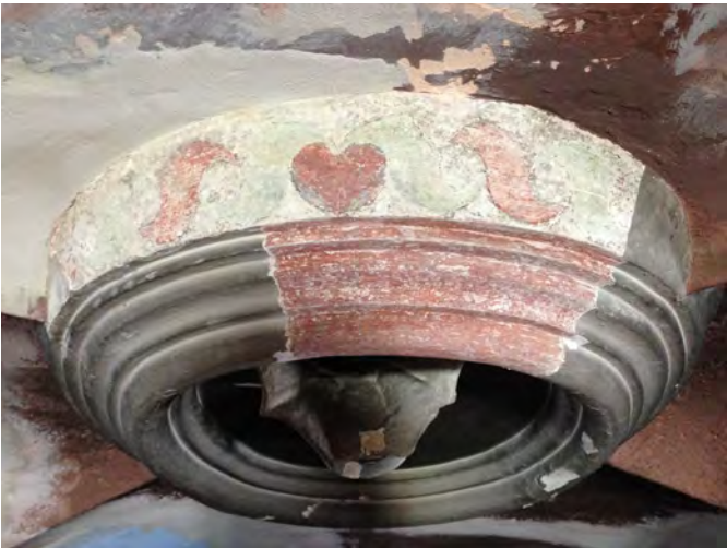
Restauration de l'église de Saint-Gervais (2016), détail d'un médaillon des voûtes (en cours de dégagement et après restauration).
