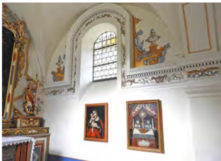
Baie du chœur et ses décors après restauration.
