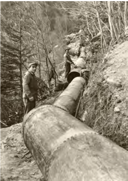
Installation d'une conduite forcée.
