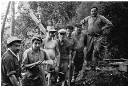
Une équipe d'ouvriers posant devant le câble qui monte les matériaux.
