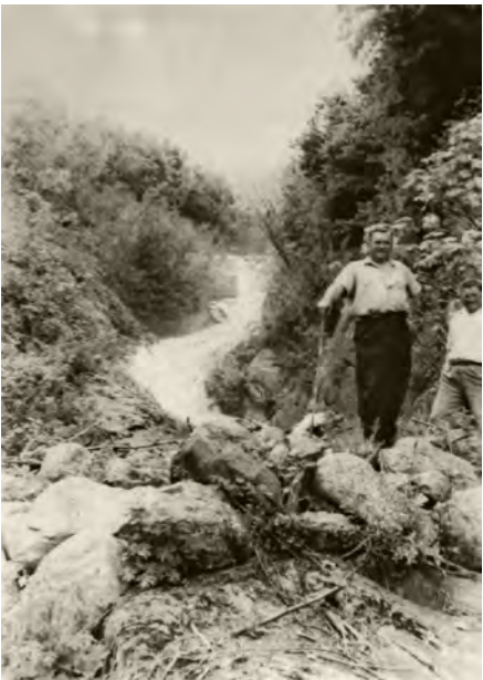
Louis-Albert Convert sur le chantier de Saint-Rémy
