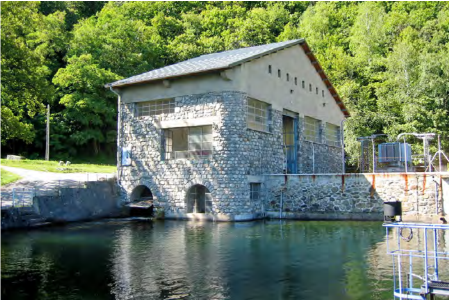
La centrale des Pérelles.
