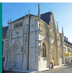
Façades de l'abbatiale de Hautecombe restaurées en 2019, programme européen Alcotra « Les Ducs des Alpes – I Duchi delle Alpi ». © CDP
