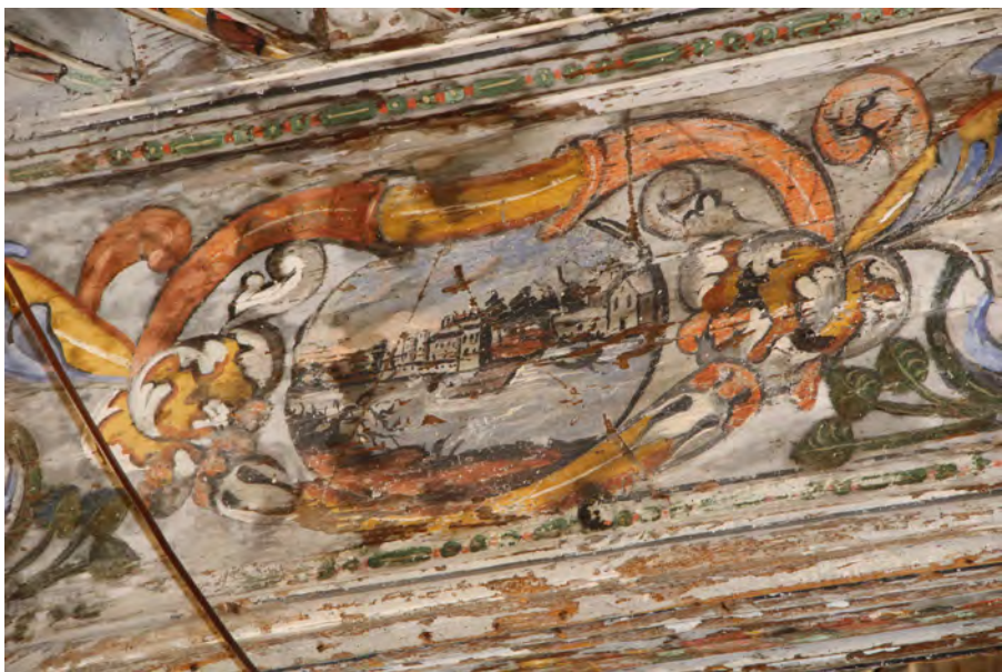
[ci-dessus] Médaillon d'une des poutres centrales: L'Hôpital et le flottage.
