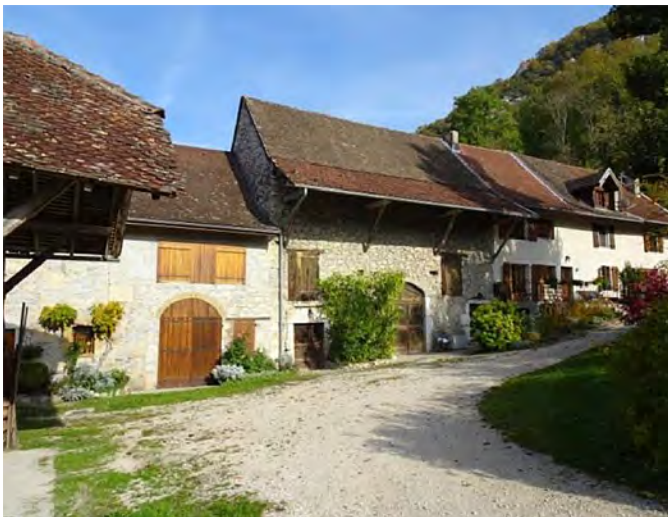
Le bâti rural est très présent, alternant anciennes granges-étables et habitations. Les restaurations sont faites avec respect du patrimoine selon les règles des Aires de mise en Valeur de l'Architecture et du Patrimoine (AVAP).
