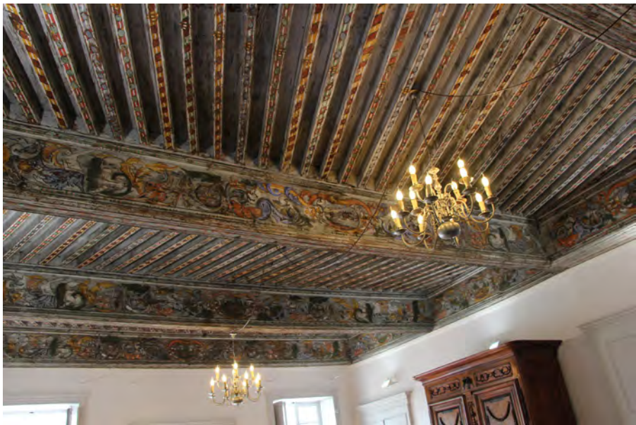
[ci-dessous] Château Manuel de Locatel, Conflans, plafond peint du grand salon, XVII e siècle. Coll. MAHA © E. Estadès.
