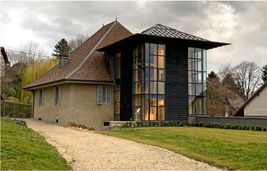
fig. 10. Le Manoir et le nouvel escalier, vue depuis la terrasse haute.
