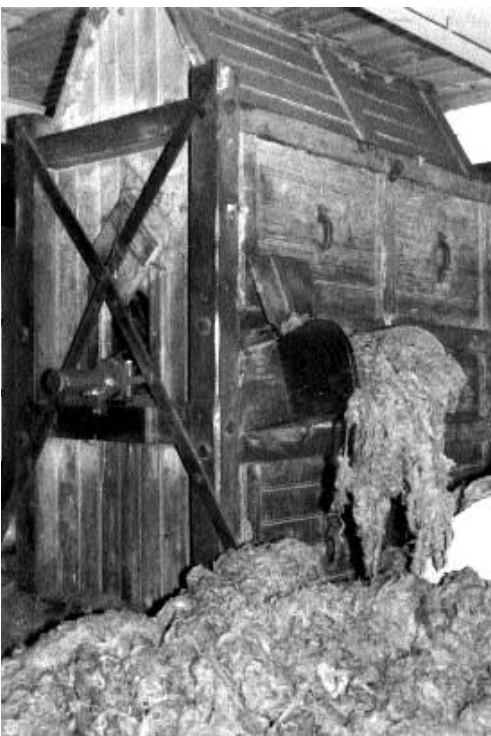
Batteur-mélangeur, servant à l'ouverture de la laine (1865).
