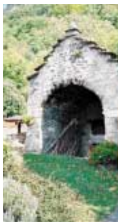
Four à pain avec pignons à redents dits en « sauts de moineau », anciennement couvert de chaume, hameau de Landernier, Motz.
