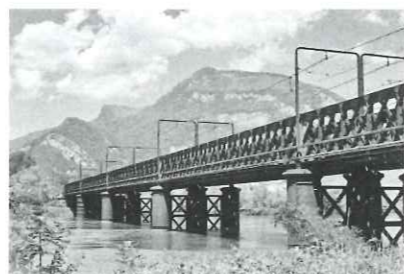
Pont de Culoz (Vions).
