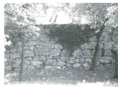
Mur de clôture (Méry).
