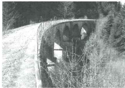
Viaduc des Fontanettes (Tréviggin).
