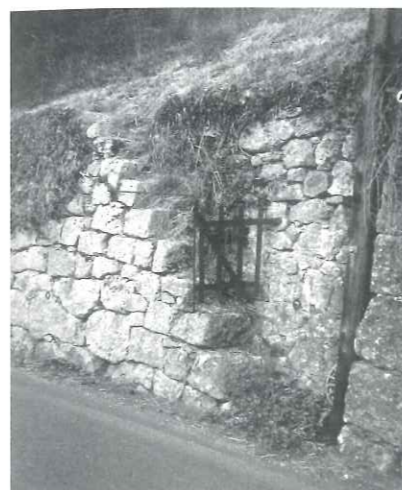
Escalier et muret de vigne (Chindrieux).
