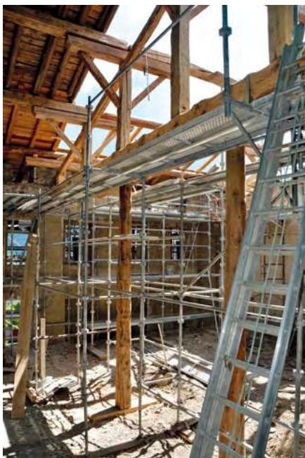
L'ampleur des travaux de charpente nécessaires à la restauration d'une couverture en lauzes avoisinant 800 m<sup>2</sup> (échafaudage de la grange, été 2024).
