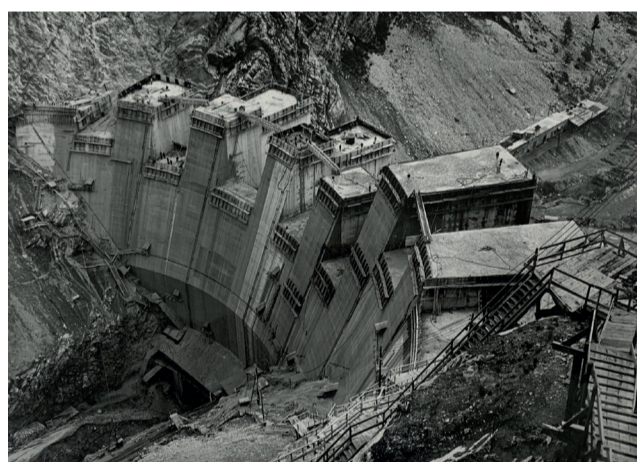
Der Bau des Chevril-Staudamms bei Tignes, André Girard, 8 août 1951 (Archives du diocèse de Tarentaise, 75P55).
