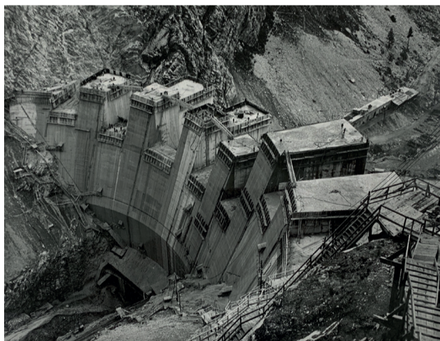
The construction of the Tignes dam, André Girard, 8 August 1951 (Archives du diocèse de Tarentaise, 75P55).
