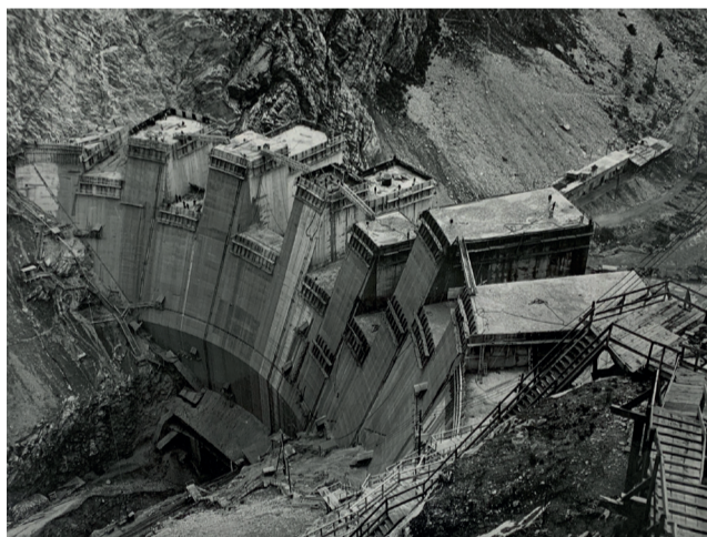
La construction du barrage de Tignes, André Girard, 8 août 1951 (Archives du diocèse de Tarentaise, 75P55).
