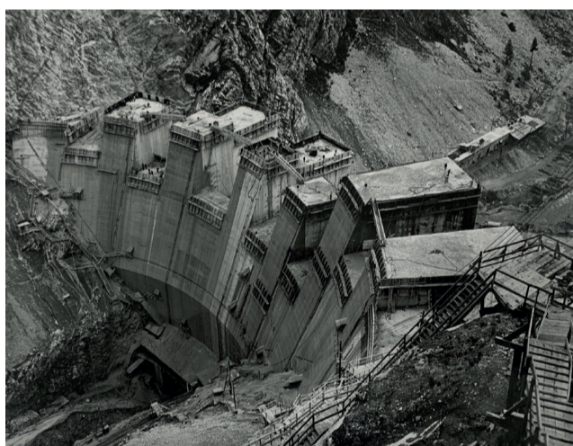
La costruzione della diga di Chevril a Tignes, André Girard, 8 août 1951 (Archives du diocèse de Tarentaise, 75P55).
