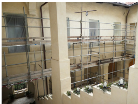
I lavori per la riapertura delle finestre.
