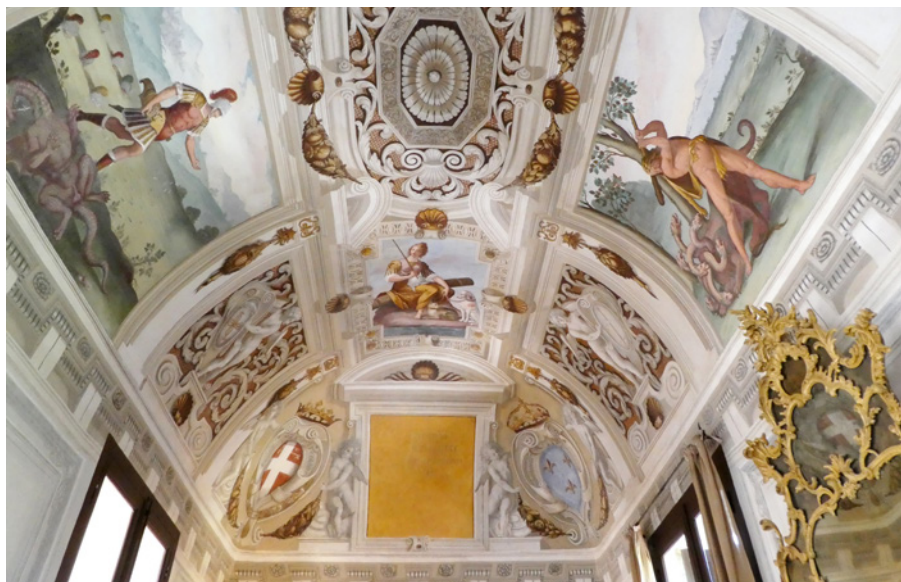
Particolare della volta della Galleria dopo il restauro (parte sud).
