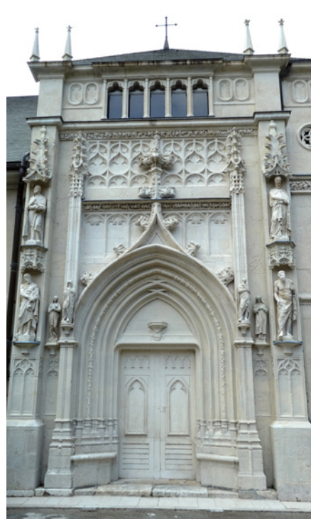
Statues originales de la façade nord en place après restauration, XVI e siècle.
