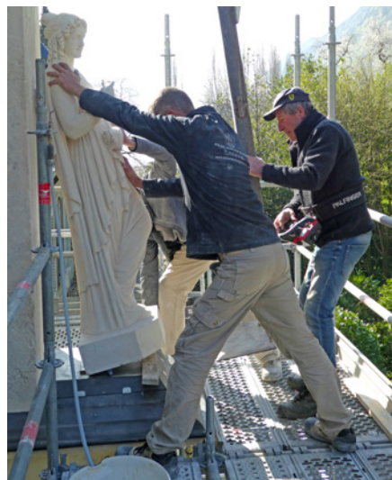
Mise en place de la copie de la statue de la Prudence en façade.
