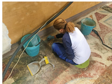
Il restauro della pavimentazione in stucco dipinto.
