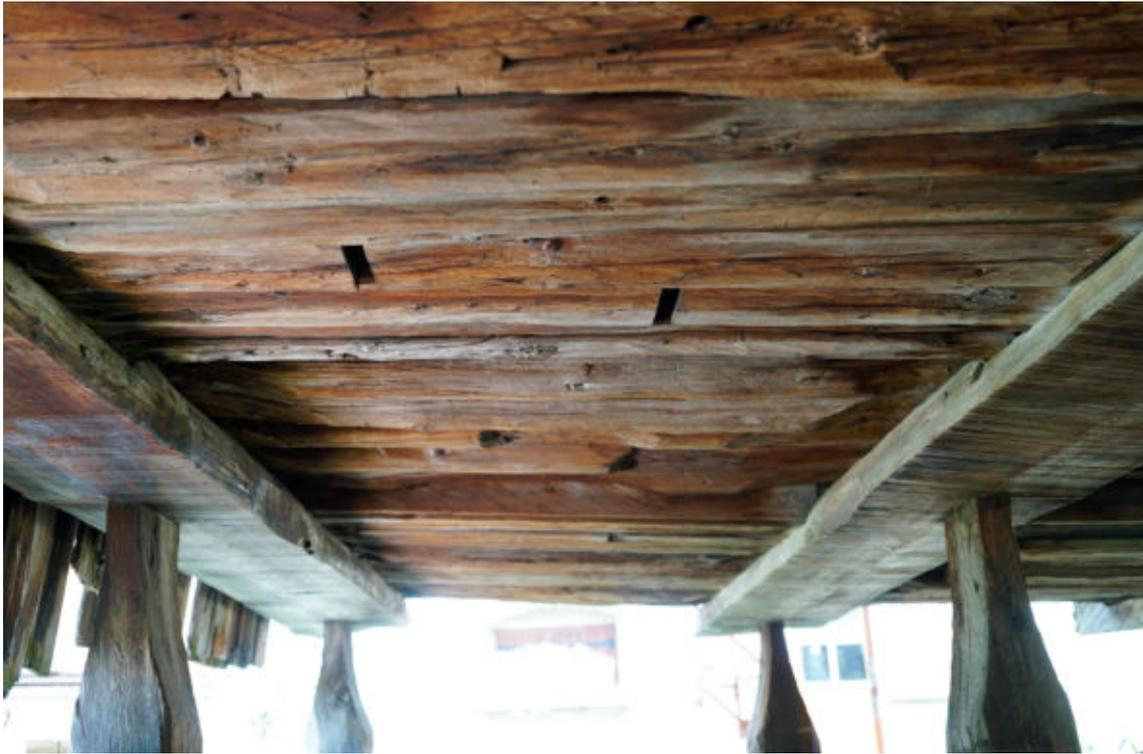
**Fig. 7 : pièces de grenier en réemploi dans le plancher du raccard, ©O. Bellanger.**
