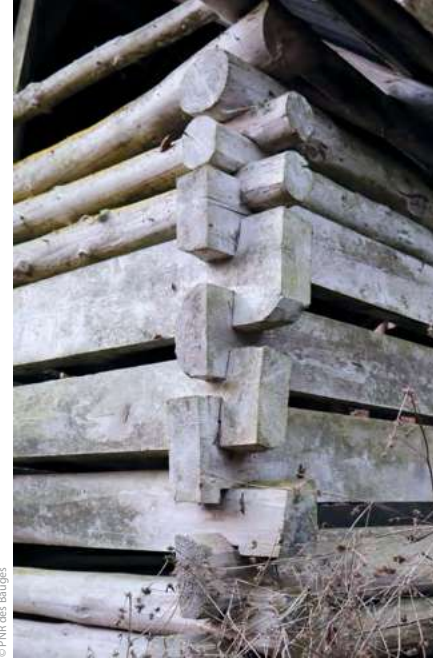
Détail d'assemblages à mi-bois d'une grangette à claires
